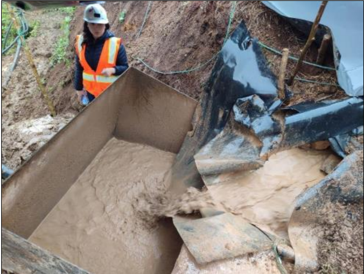
Figura 18. El agua y los relaves que se descargaron de la Piscina No. 15 se recolectaron en un recipiente metálico y luego se transfirieron a la Piscina Nro. 9 (ver Fig. 4). Foto de Municipio de Cotacachi (2023a).
