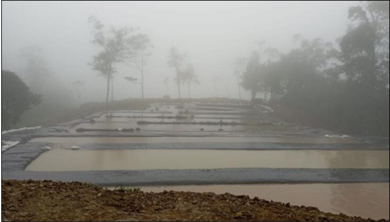
Figura 5. Los relaves húmedos que quedan del procesamiento del mineral de oro con cianuro en la mina El Corazón se almacenan en una sucesión de piscinas de relaves (ver Fig. 4). No hay indicios de que el cianuro se destruya (oxidado) antes de su depósito en las piscinas de relaves, por lo que se debe suponer que el agua de las piscinas de relaves está enriquecida en cianuro. Foto de Agencia de Prensa Minera (2023).
