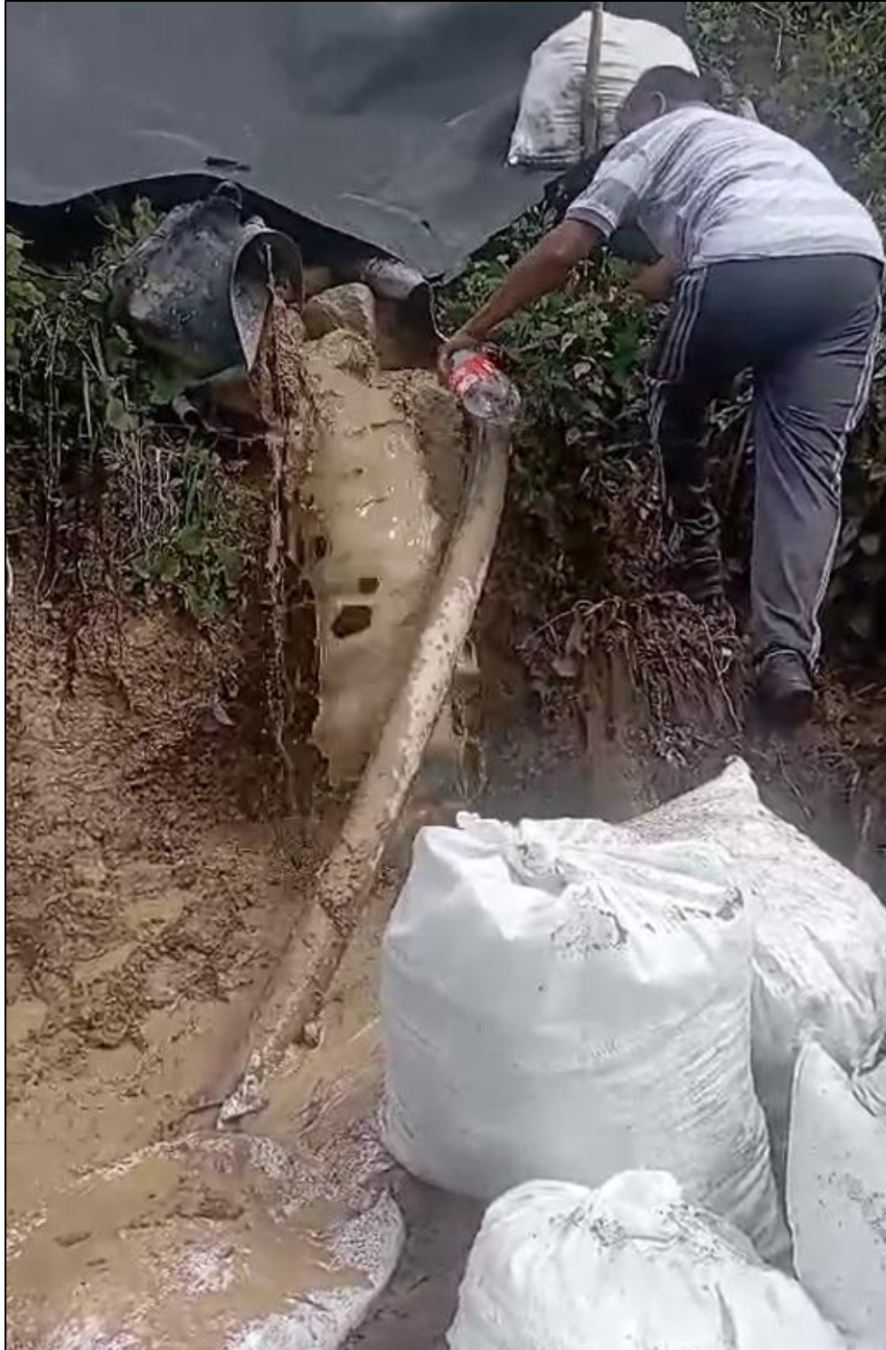
Figura 6. El día de la falla de la presa de relaves (4 de noviembre de 2023), un residente local lucha por ganar pie en el empinado terraplén para recolectar una muestra de agua de la presa con fugas (ver los resultados del análisis de agua realizado por Laboratorio Anncy (2023) en Tabla 1 ). La alta inclinación del terraplén se indica además por la inclinación de la tubería, las raíces de las plantas expuestas y la caída casi vertical de agua contaminada de la piscina de relaves. Foto fija a las 0:04 del video proporcionado por la Asociación de Propietarios de Tierras Rurales del Norte y el Frente Antiminero (etiquetado Video 1 por el autor). Otra foto fija del mismo video está disponible en Municipio de Cotacachi (2023a).
