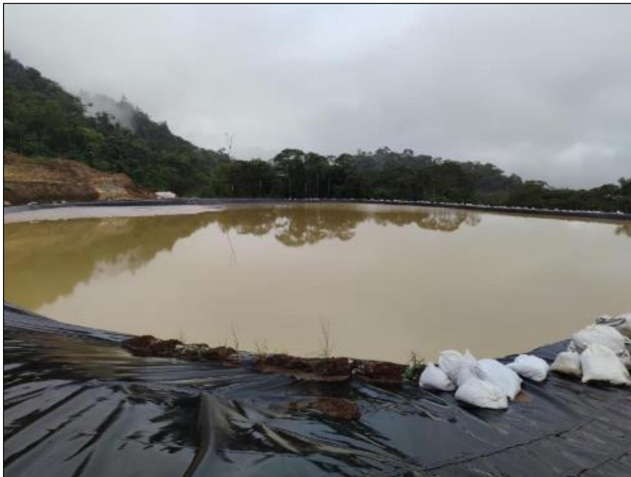
Figura 13. La Piscina No. 15 de la mina El Corazón contenía alrededor de 50.000 metros cúbicos de agua y relaves antes de la falla de la presa de relaves el 4 de noviembre de 2023. Foto de Municipio de Cotacachi (2023a).
