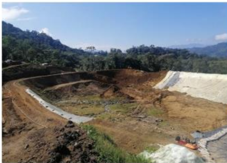
Construcción de drenes en la base de la relavera (foto de archivo)
