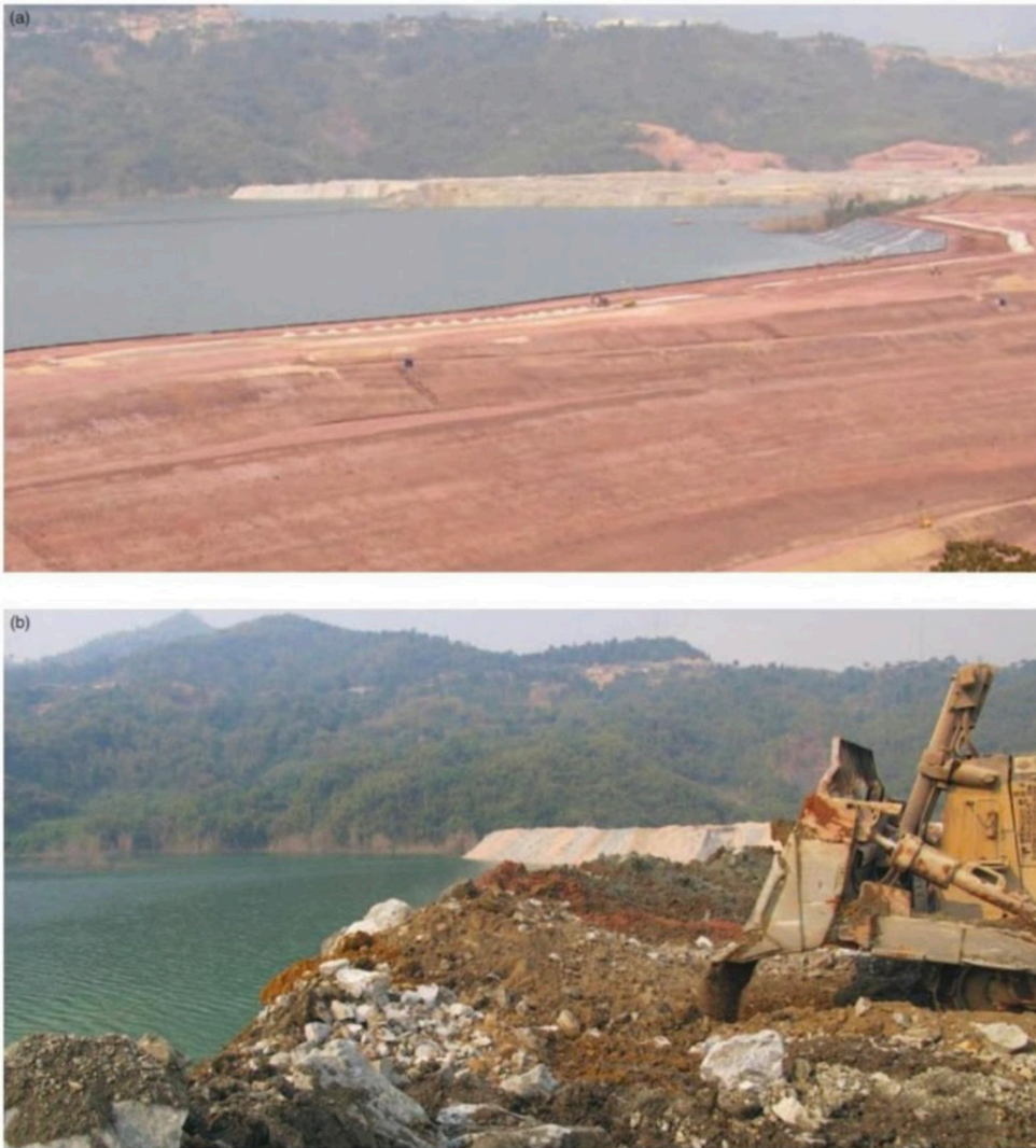
Figura 15.3: (a) Deposición de roca estéril en la instalación de almacenamiento de relaves, (b) empuje de capas de roca estéril hacia el estanque de relaves. Fuente: W Wilson
