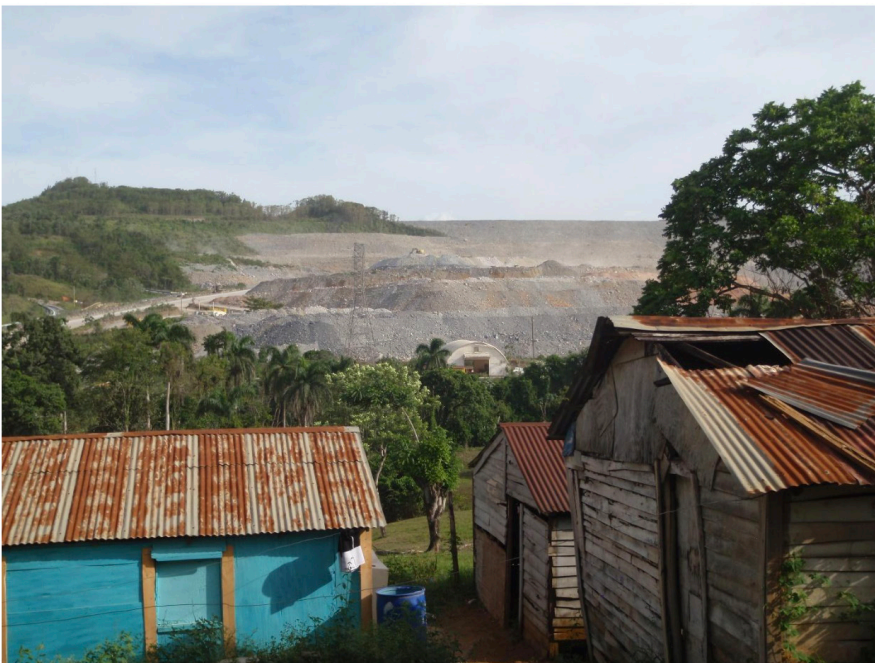
FIGURA 3. El camino probable para el flujo de relaves luego de la falla de la TSF (Instalación de Almacenamiento de Relaves) propuesta Naranjo es el arroyo Vuelta, que fluiría por debajo de la instalación de almacenamiento de relaves. El camino probable llevará los relaves a las comunidades de Las Lagunas y La Cerca, así como a gran parte de la infraestructura de la mina. De manera similar, una falla de la TSF El Llagal existente llevará los relaves a las comunidades de Las Lagunas y La Cerca, además de gran parte de la infraestructura de la mina. Tanto para las instalaciones de almacenamiento de relaves existentes como para las propuestas, las consecuencias se han clasificado como Extremas, lo que significa que se esperan más de 100 muertes como resultado de la falla de la presa. Fronteras provinciales de ESRI (2021) y perímetros de TSF rastreados de Knight-Piésold Consulting (2022). Ver mapa a mayor escala en Fig. 2.
